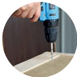
Přípevnění krytu stropu
